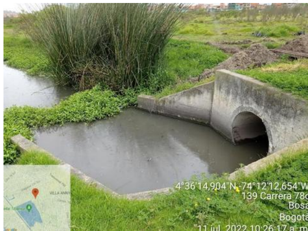
Figura 37. Ingreso de agua contaminada por uno de los colectores pluviales que descarga en el humedal de Tibanica.
