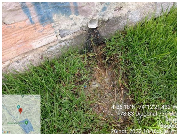
Figura 38.. Tubería de 3 pulgadas con zona húmeda proveniente de una vivienda al interior del humedal de Tibanica.
